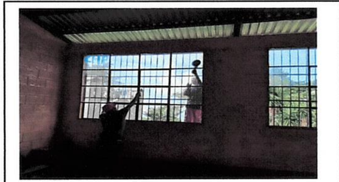
Foto 3: Cambio de ventanas a Tipo PVC
